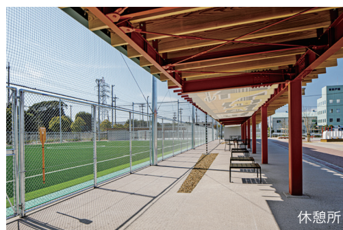
管理棟南側外観
