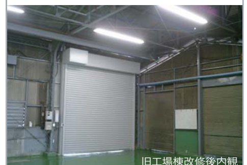
旧工場棟改修後内観
