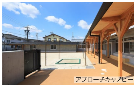
木造増築棟底下
