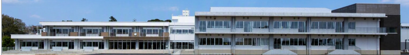
改修後（第4期完了時）：南側外観
