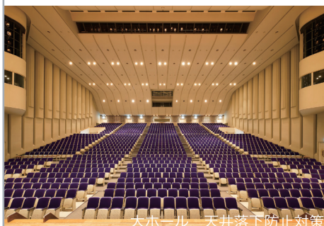
大ホール 天井落下防止対策
