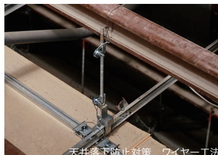
天井落下防止対策 ワ이어工法
