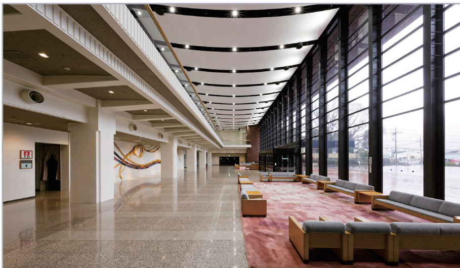
特定天井の改修工事が完了しました。
