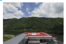
屋上ヘリポート
