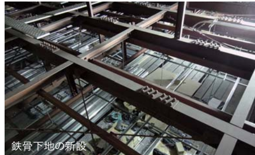
鉄骨下地の新設
