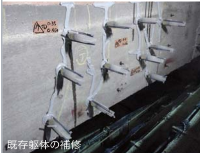
既存躯体の補修
