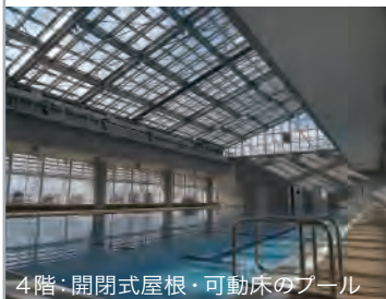
4階・開閉式屋根・可動床のプール
