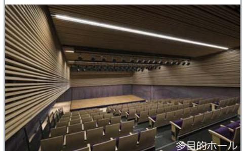
市民利用に適した規模に、木を基調としたインテリア、舞台機構、舞台音響、移動観覧席を有した、段床形式・平土間形式を実現する可変性の高いホール(NC-25、定員202名)です。生音のクラシックコンサート時に豊富な反射音が得られる室形状を採用し、多面傾斜壁やルーバーと合せて、反射音を散乱させて音を和らげるようにしています。演劇や講演会など、音の明瞭度が求められる催し物の場合は、ルーバーの背面に吸音カーテンを引出し、響きの長さを短く調整可能な仕様としています。
