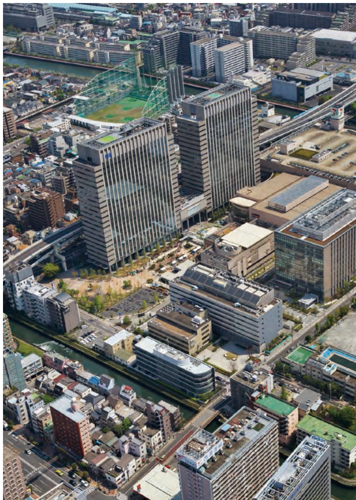
深川ギャザリアタワー S棟・N棟 東京／ 2007 S・SRC-2+22 / 83,220m 2
