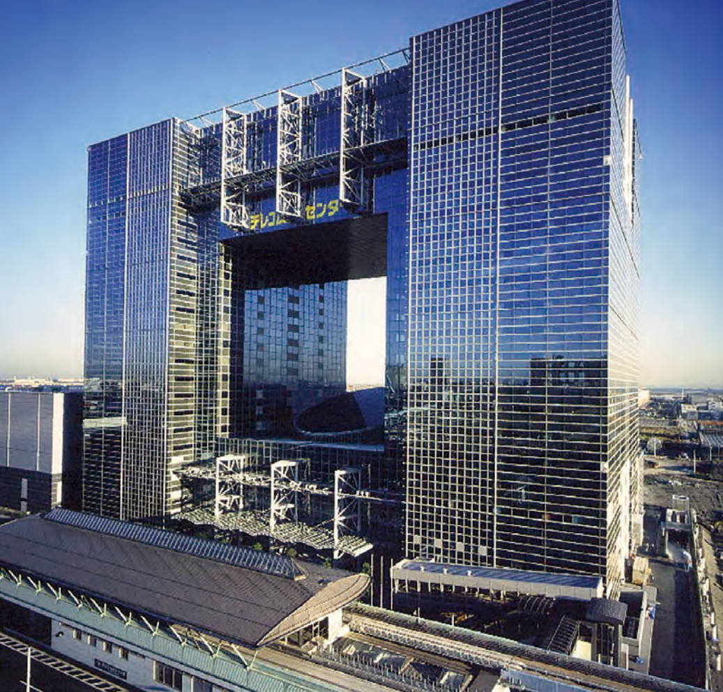
テレコムセンタービル 東京／1995 SRC・S-3+21／157,519m 2 照明普及賞・SDA賞パブリック部門入選
