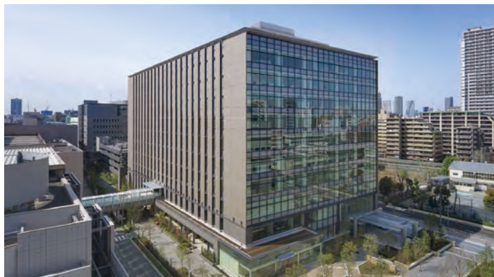
深川ギャザリア W2棟 東京／2010 S・RC-1+10 / 37,505m 2
