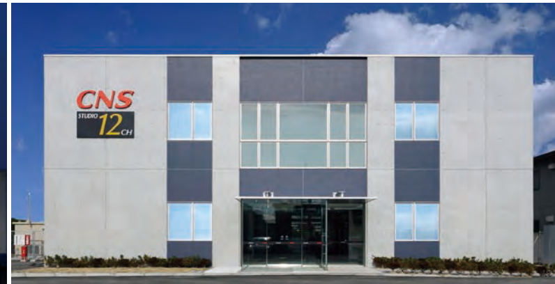
ケーブルネット 鈴鹿新館 三重／2009 RC+2 / 708m 2
